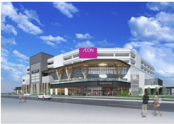
店舗 南東（駅側）の外観【日中】
