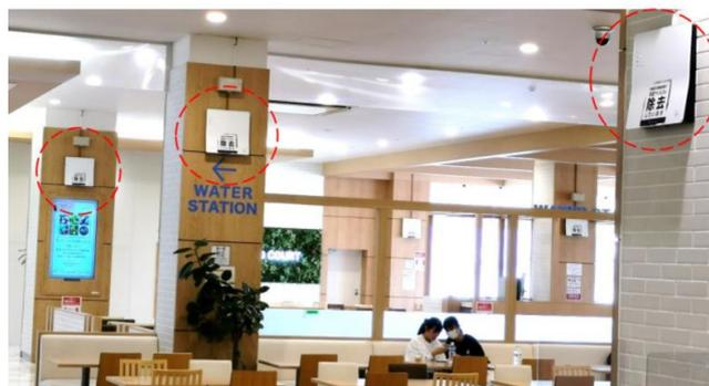
▲フードコート柱への光触媒方式除菌器設置の様子（イオンタウン始良）
